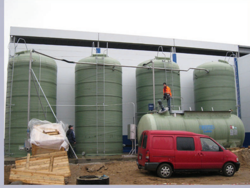
Suolaliuosaseman ja varastosäiliön asennus
